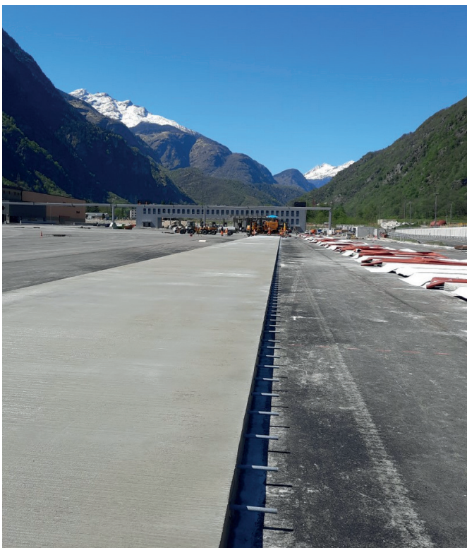
Bild 3 Fertiger Fahrbahnstreifen mit Dübeln zum Anschluss der Nachbarplatte
