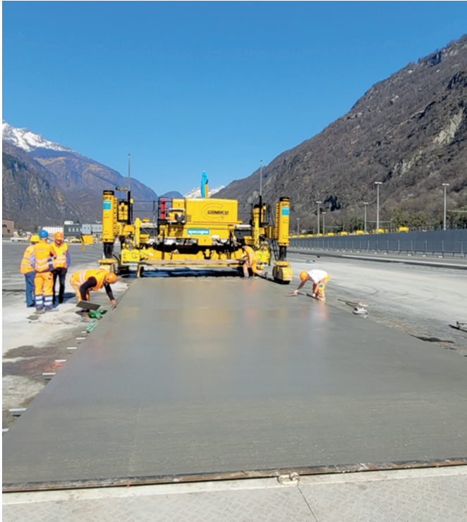
Bild 1 Gleitschalungsfertiger in alpiner Landschaft
