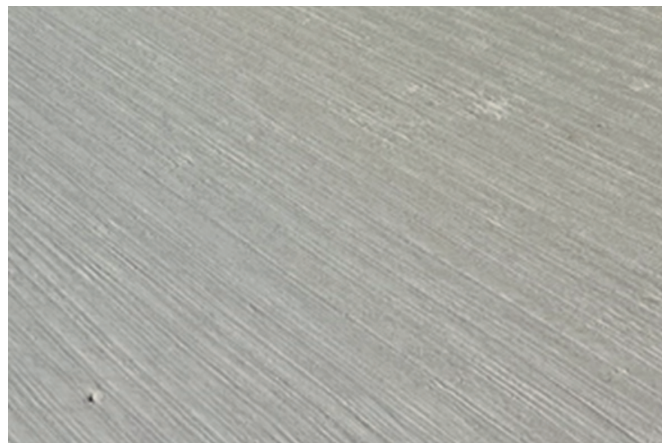
Bild 6 Besenstrichtextur auf der fertigen Betonoberfläche
