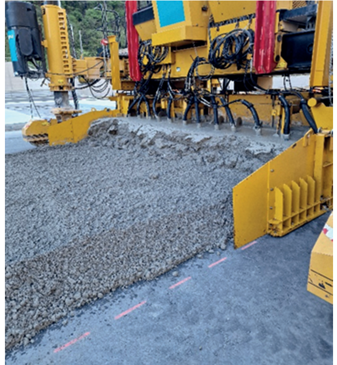
Bild 2 Verdichtungseinheit am Gleitschalungsfertiger
