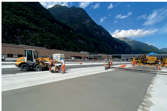
Bild 5 Herstellung einer Ergänzungsbahn zwischen zwei fertigen Fahrbahnstreifen
